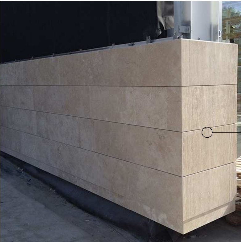
Esempio di posa rivestimento di travertino
